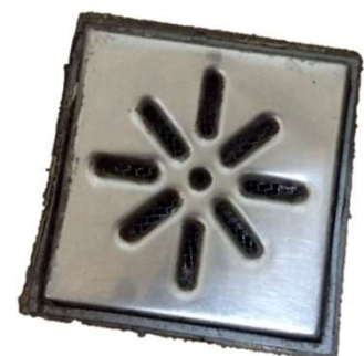
6) Poskładaj oczyszczone elementy: Osadź zawór, zabezpiecz go zaciskiem, załóż sitko i pokrywkę
