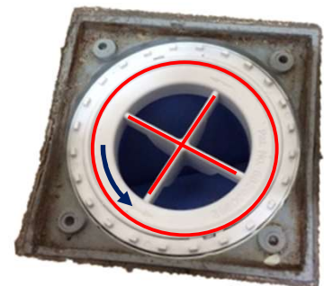
3) Odkręć delikatnie w lewo ( \sim 10^\circ ) środkowy zacisk (zaznaczony kolorem czerwonym)
