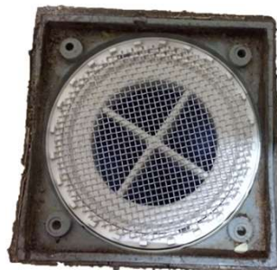
2) Podnieś i przepłucz sitko pod bieżącą wodą (kurz, włosy, itp.)
