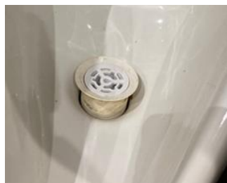
Rozkręcone gniazdo zaworu z ceramiką pisuaru
